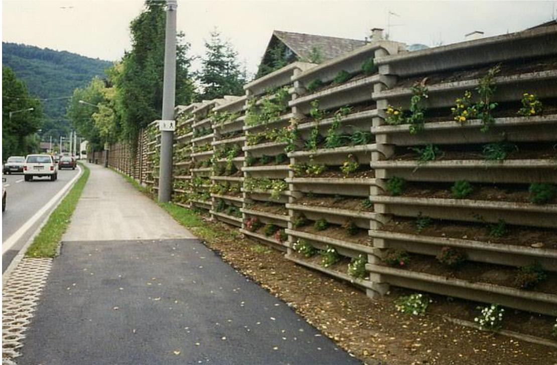
Figura 3-3 Esempio di barriera vegetale mista con calcestruzzo
